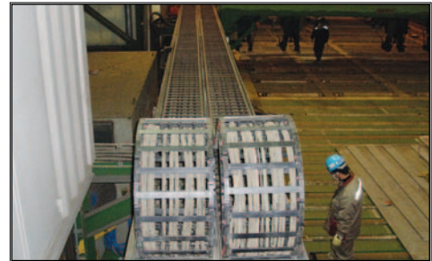
⬇ Linea di saldatura costruzione navale
