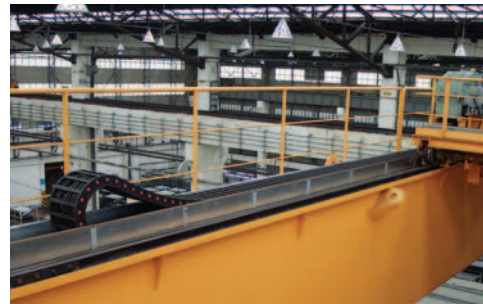
➤ Applicazione su gru di sollevamento
